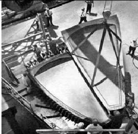
8. ábra Saturn V indítórakéta 10 m átmérőjű alkatrésze 19
