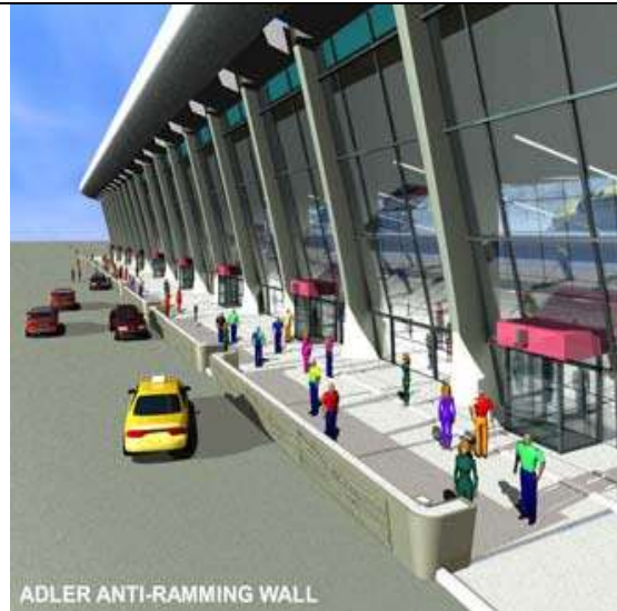
1. ábra Védő lábazat a terminál épülete előtt 5
